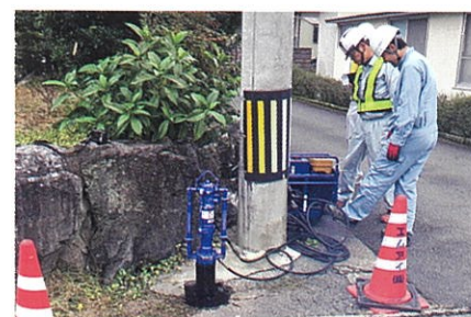
2m程度のスペースで施工可能です。
